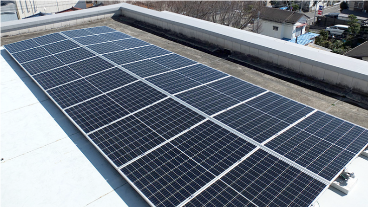
太陽光システムの設置イメージ ※屋上に最適な「置くだけ設置」の陸屋根専用架台
